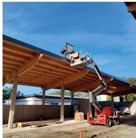
Abschluss der Dachbegrünung und Montage der Paneele für die PV-Anlage
