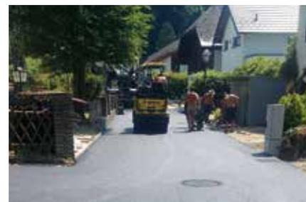
oben: Im Bereich Seewinkl wurden Oberflächen- und Schmutzwasserkanal, Wasserleitung und Straße saniert und die Strom- und Datenleitungen der Salzburg AG mitverlegt.
