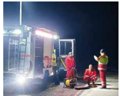
Kamerabefahrung mit Tauchroboter
