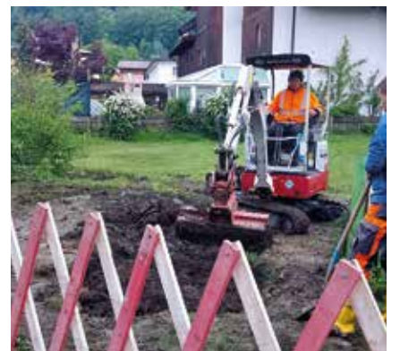
...Der Schaden wird behoben
