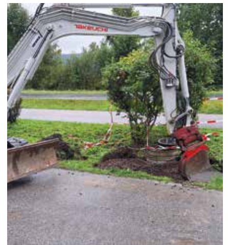
Sickermulde Parkplatz Nord
