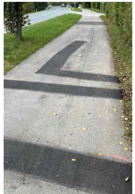
Sanierung der Radwege Richtung Überfuhr sowie im Bereich Mitterhof.
