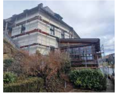
Sanierung der Fassade
