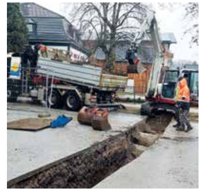
Ausbau der Nahwärme
