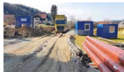
Erschließungsarbeiten Privatgrundstück Hofgartenweg
