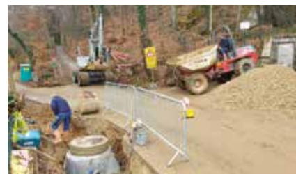
Sanierung Oberflächenwasserkanal und Wasserleitung Baustelle Ramooser Straße/Saulachstraße
