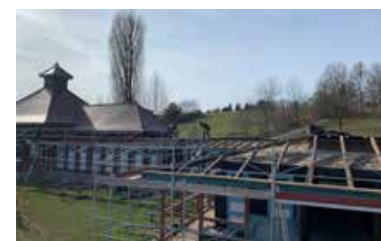
Sanierungsarbeiten im Strandbad
