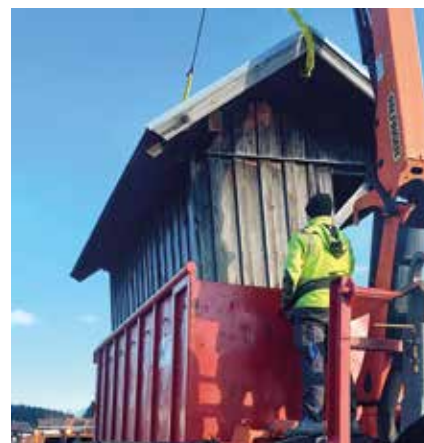
Abbau Buswartehaus Moorbad
