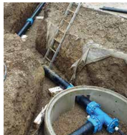
Hauptwasserleitung wurde verlegt
